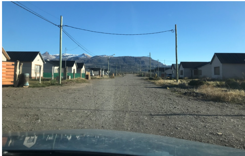
Fig. 27: Barrios con calles sin pavimentar y ausencia de veredas.
