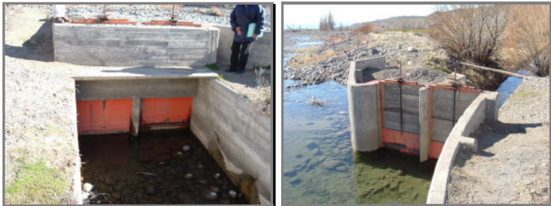
Fig. 12: Boca de toma captación río Los Antiguos- Ministerio de Planificación
