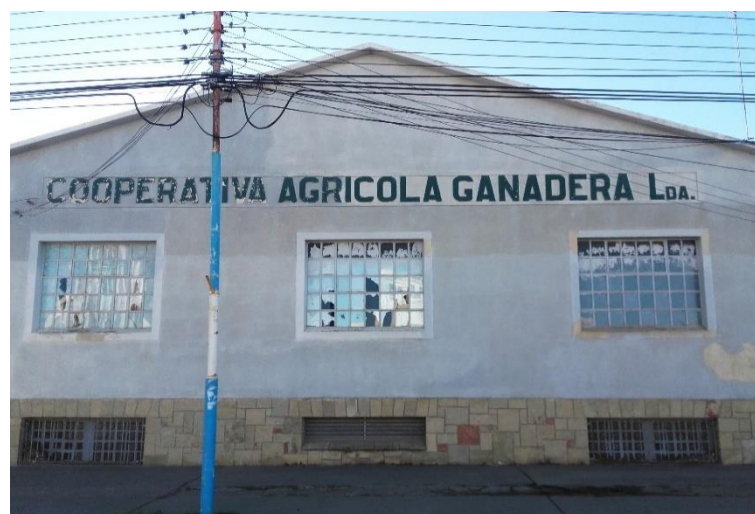
Fig. 113: Ventana de vidrio repartido en Puerto San Julián.
