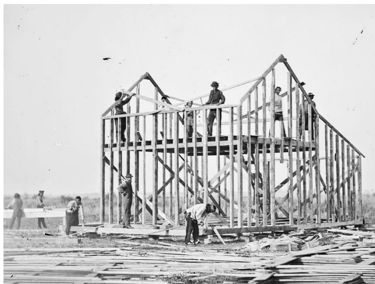
Fig. 109: Sistema de construcción Balloon Frame.
