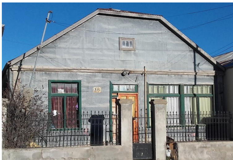
Fig. 117: Cerco en vivienda de Puerto San Julián.
