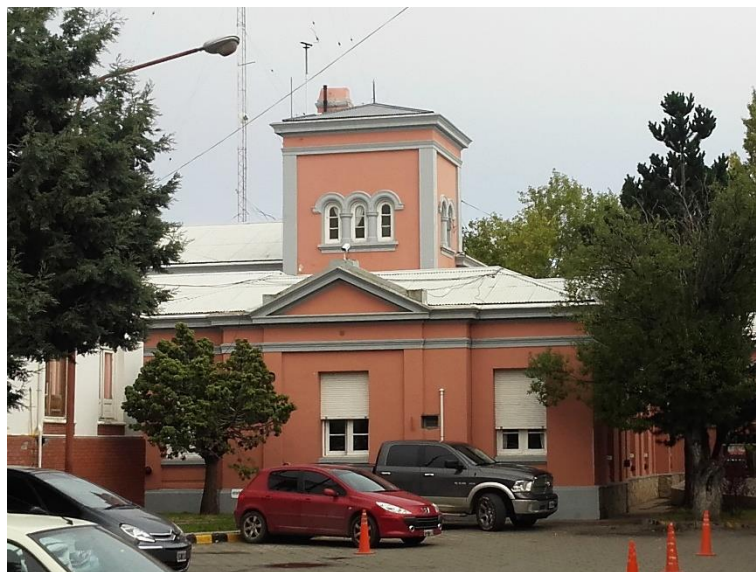
Fig. 112: Torre en la Casa de Gobierno Provincial de Río Gallegos.
