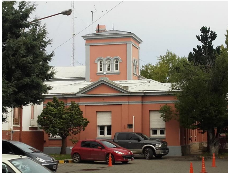
Fig. 22: Torre en la Casa de Gobierno Provincial de Río Gallegos.
