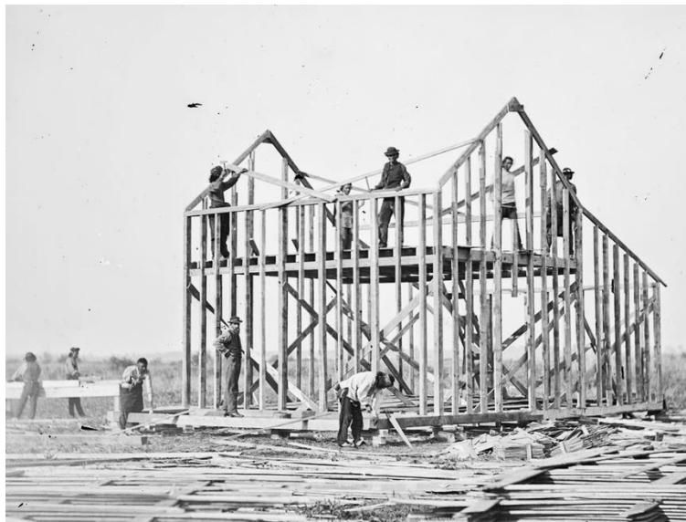
Fig. 19: Sistema de construcción Balloon Frame.
