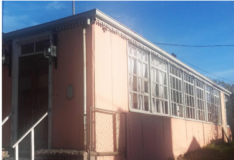
Fig. 20: Galería en vivienda de Río Gallegos.
