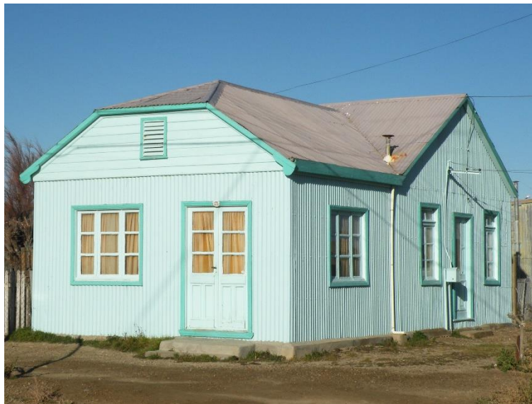
Fig. 18: Revestimiento de chapa en vivienda de Puerto San Julián.
